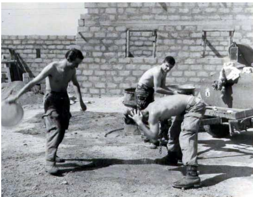
1960_09_050 Toilette matinale au Bordj, en construction, de la cote 120.
