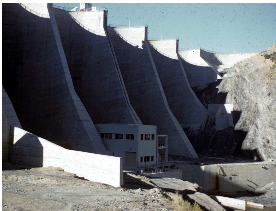
Ref : 061-08 Le barrage d'Erraguene
