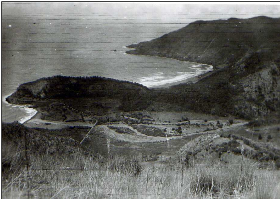
1961_09_114 Sur les collines au-dessus de DJIDJELLI.
